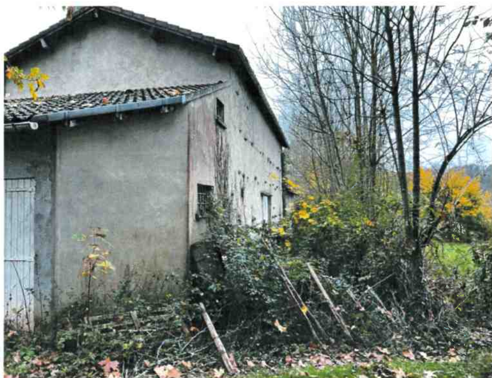
L'extérieur du bâtiment servant d'habitation vu du chemin rural
