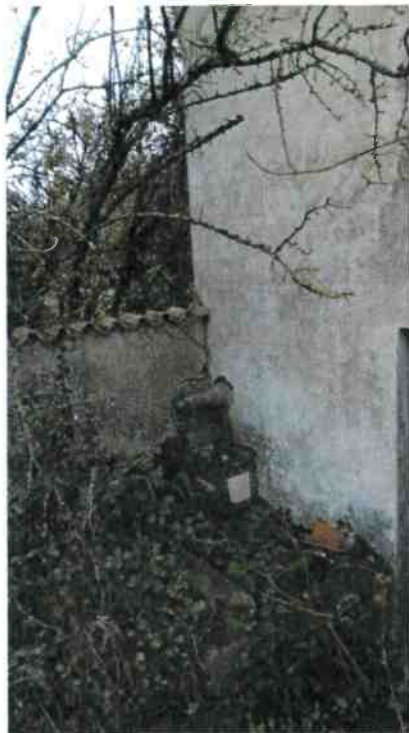
Regard eaux ménagères supposé
